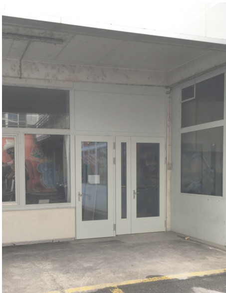
Pose de portes EI30
