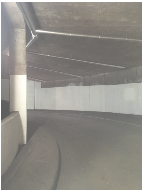
Pose de sprinkler avec câble antigel
