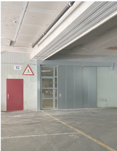
Installation d'un compartimentage et d'une voie de fuite
