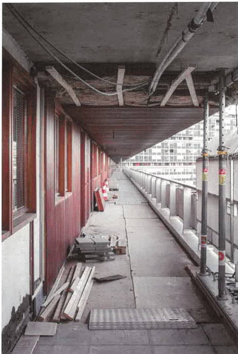
Travaux d'entretien et de réfection de la coursive du 4e étage.
